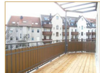
Die Böden der Balkone erhalten eine wasserdichte Wanne mit Gefälle und eine integrierte Entwässerungsrinne mit eingebundenem Ablauf. Die Nutzböden bestehen aus kesseldruckimprägnierten Holzlattenrosten mit rutschhemmender Oberfläche.
